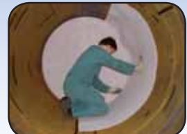
Lining the tank with interstitial fleece Habillage de la cuve avec le feutre intermédiaire Revestimiento del depósito con la capa intermedia de fieltro
