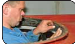
Fixing the sealing strip Fixation du joint d'étanchéité Fijación de la banda de aislamiento
