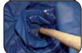
Inflating the Tank liner Gonflage du réservoir intérieur souple Inflado de la funda interior del depósito
