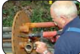
Preparation at the dome-shaped tank cover Préparations sur le couvercle du dôme Preparativos en tapa abovedada
