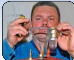
Installing the suction pipe and stop valve Montage de la conduite d'aspiration et du blocage des liquides Montaje del tubo de aspiración y del bloqueo de líquidos
