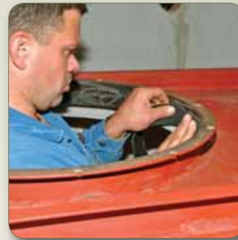
Befestigen des Dichtgummis am Dom
