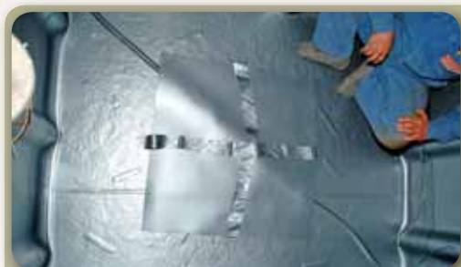
Standortgefertigter Stahltank mit montierter Innenhülle
