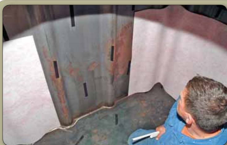
Auskleidung des Tanks mit Schutzvlies
