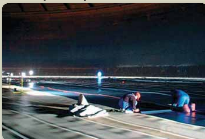
Installation einer kontrollierbaren Abdichtung in einem Flachbodentank
