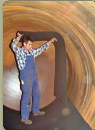
Auskleiden eines Erdtanks mit Zwischenlage
